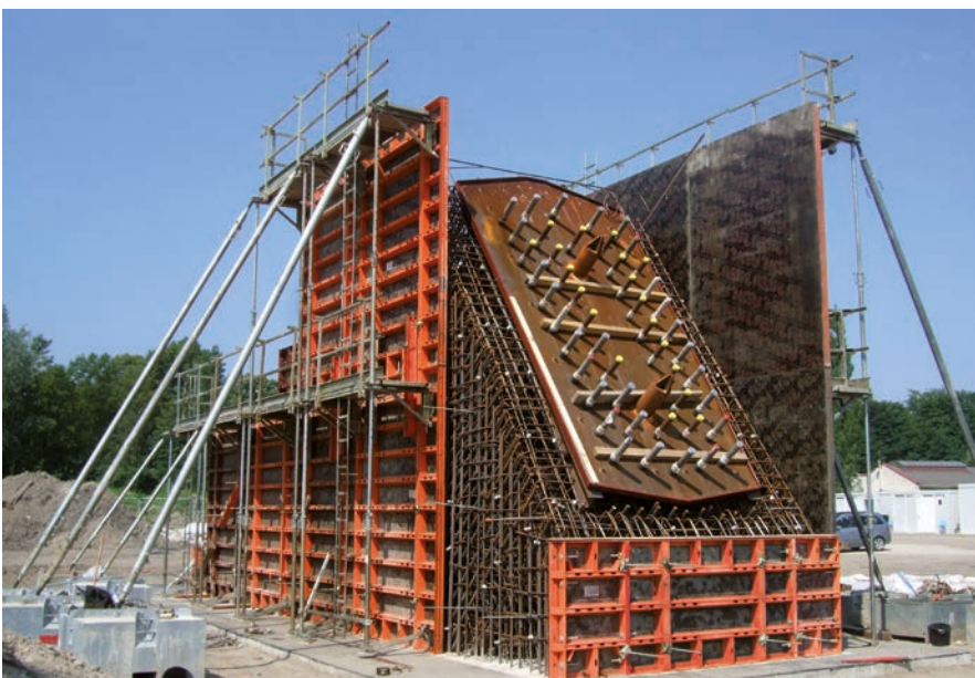
Bridge abutment „Pont Citadelle“, F-Strasbourg; GTM Halle
