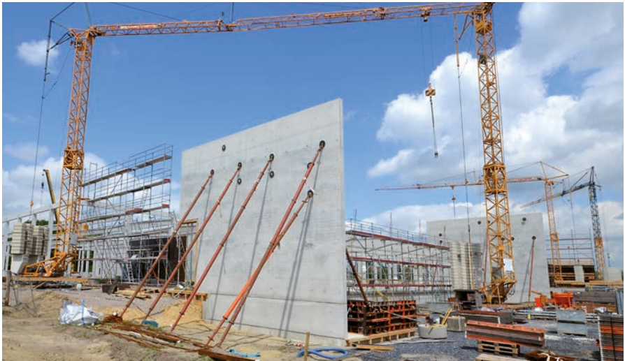
Production hall, D-Telgte; August Gründker Bauunternehmen & Bedachungen GmbH, D-Glandorf
