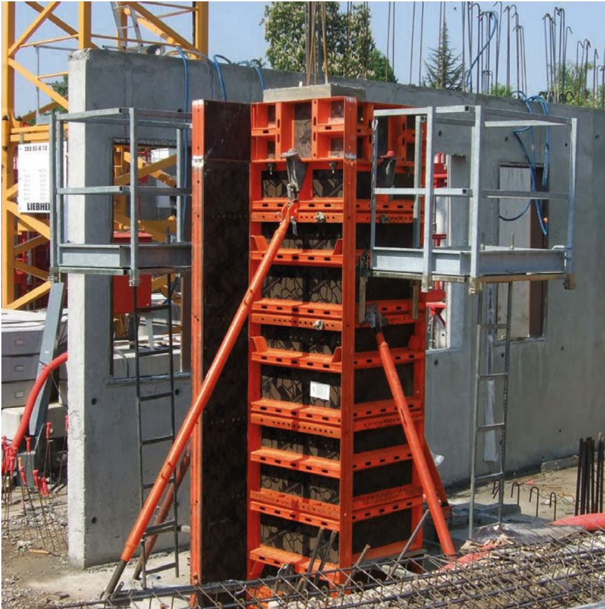
Hospital, F-Straßburg; Eiffage Construction Alsace, F-Oberhausbergen
