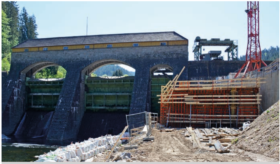
Bridge construction Bartrup bypass; Fa. Bauunternehmung Wilhelm Becker GmbH & Co. KG
