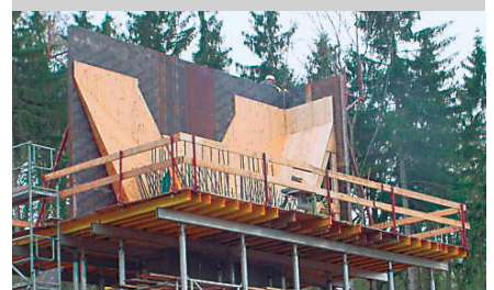
Bypass road Hettstedt; Fa. Umwelttechnik u. Wasserbau, Emsleben
