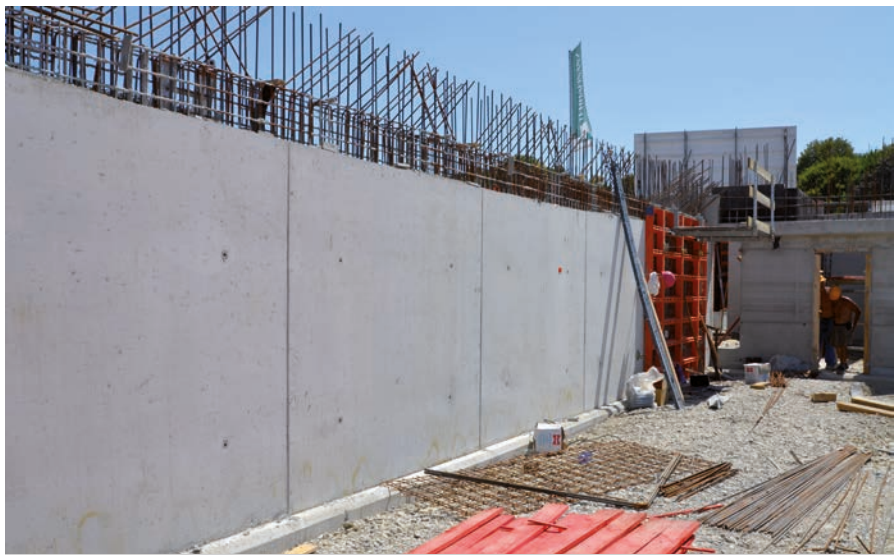
Residential complex, D-Munich; S. Pöttinger GmbH & Co. KG Bauunternehmung, D-Ottobrunn
