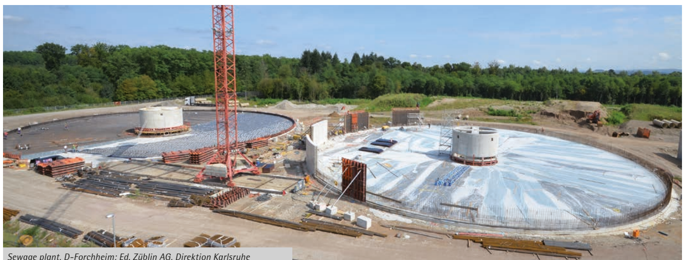
Sewage plant, D-Forchheim; Ed. Züblin AG, Direktion Karlsruhe
