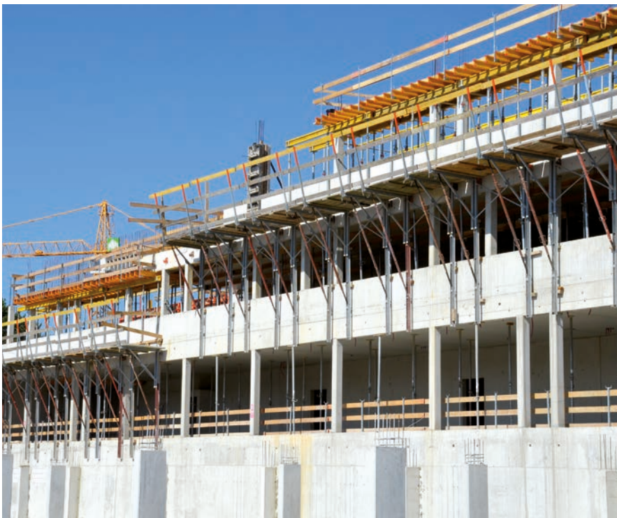
Technical college D-Holzkirchen; Bauunternehmung Ehrenfels GmbH, D-Karlstadt
