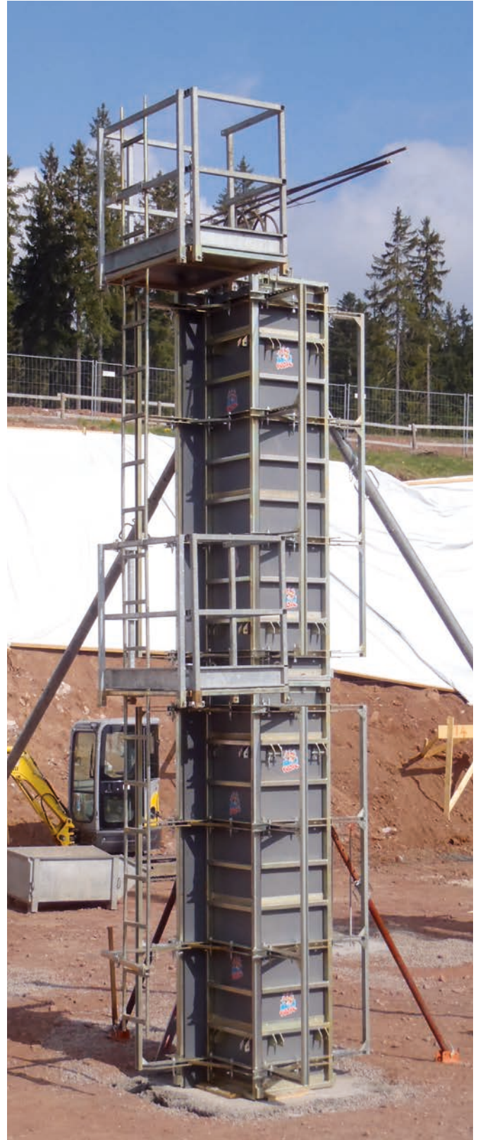
Expansion production hall Pfeiffer, D-Friedenweiler; Co. Rombach GmbH; D-Titisee-Neustadt
