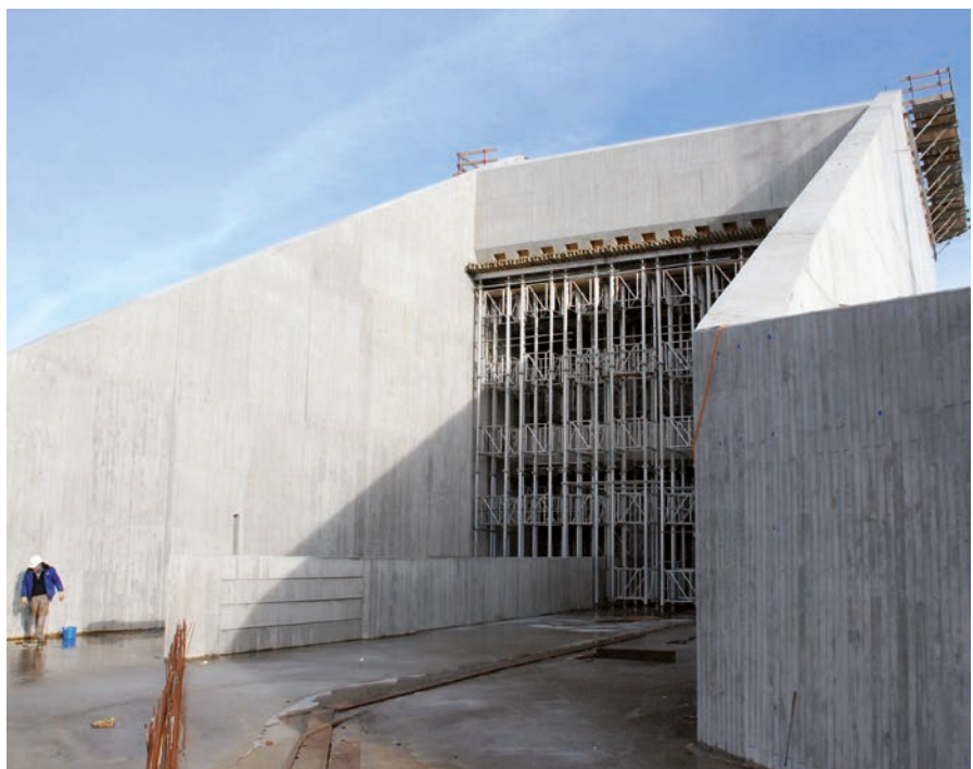
Retention reservoir, Wolterdingen; Emil Steidle GmbH & Co. KG, Sigmaringen
