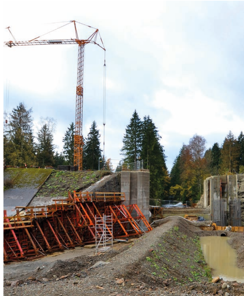
Complete renovation of the downstream reser-voir on the Sösetalsperre dam; Umwelttechnik & Wasserbau GmbH, D-Blankenburg/Harz
