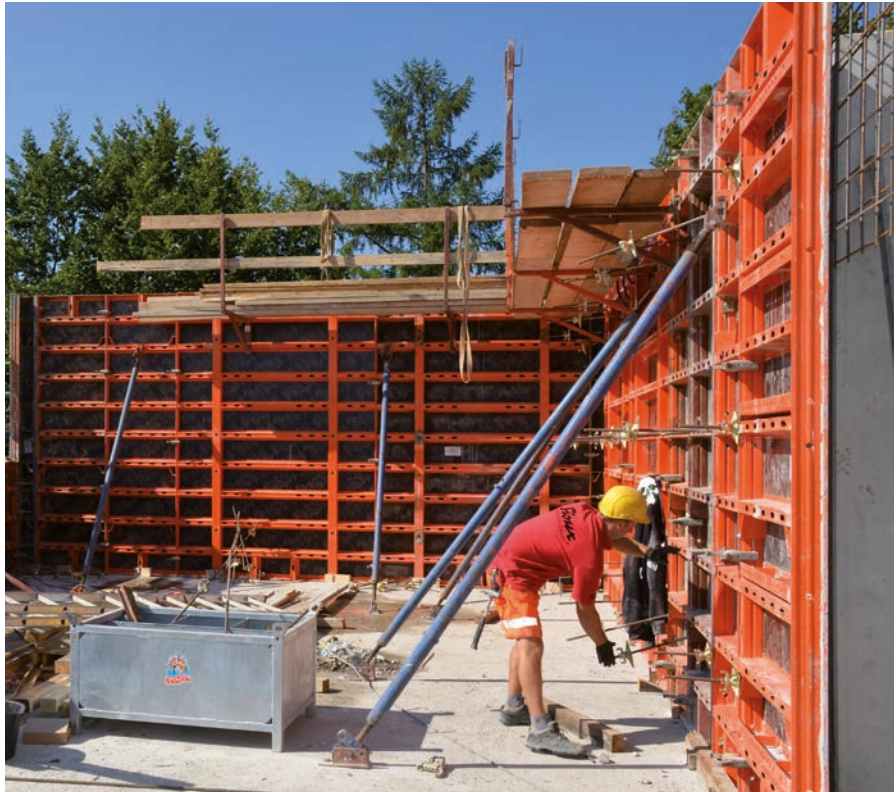
Technical college, D-Holzkirchen; Bauunternehmung Ehrenfels GmbH, D-Karlstadt
