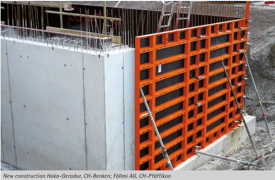
New construction Haka-Gerodur, CH-Benken; Föllmi AG, CH-Pfäffikon
