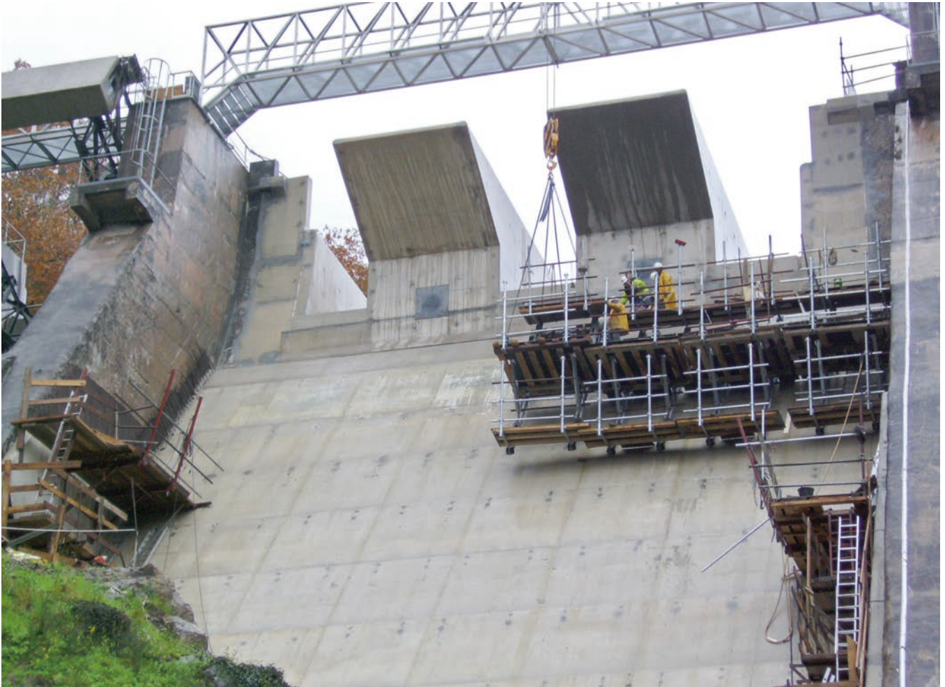
Barrage de St. Marc; Eiffage TP Agence Clermont-Ferrand, Resirep
