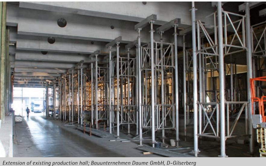
Extension of existing production hall; Bauunternehmen Daume GmbH, D-Gilserberg
