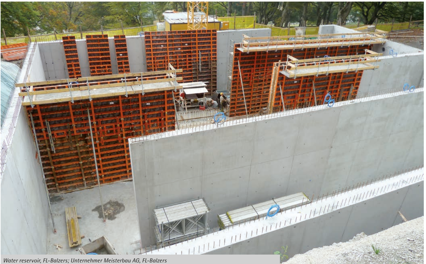
Water reservoir, FL-Balzers; Unternehmer Meisterbau AG, FL-Balzers
