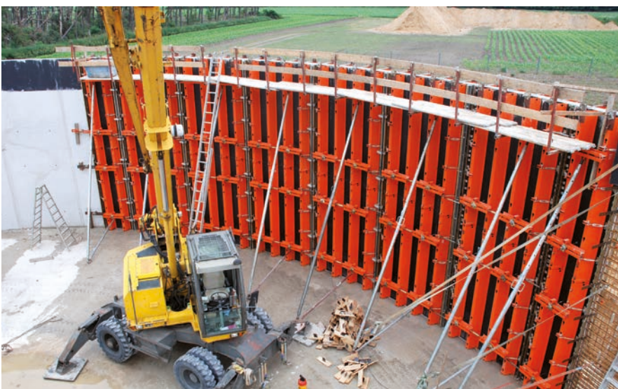
Biogas plant, D-Meppen; Baugeschäft H. Wösten GmbH, D-Haren-Altenberg
