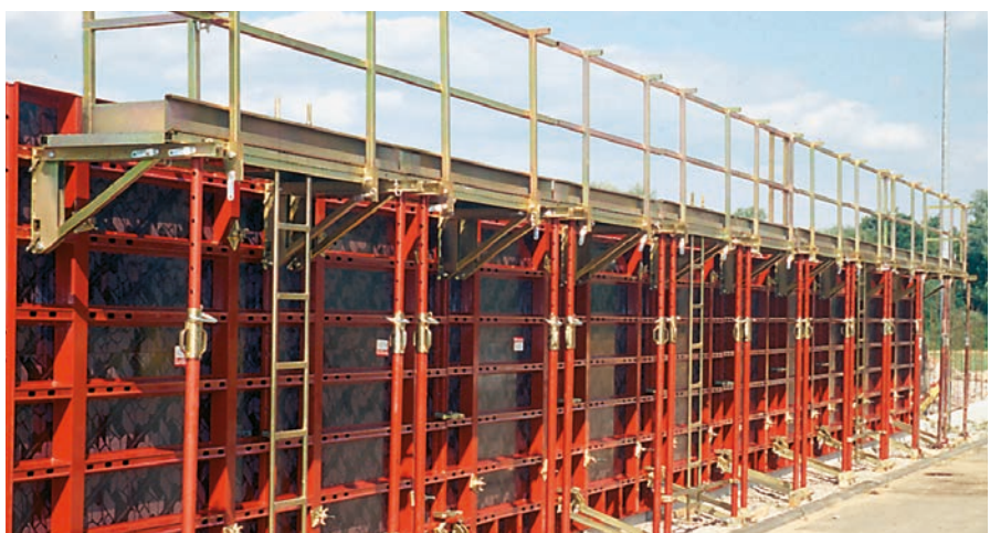
Composting plant, F-Pfaffenhofen; Krummhorn Sarl., F-Bitschoffen
