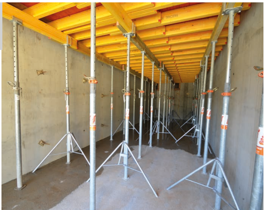
„Schierker Feuerstein-Arena“ winter sports facilities; Umwelttechnik und Wasserbau GmbH & STRATIE Bau GmbH
