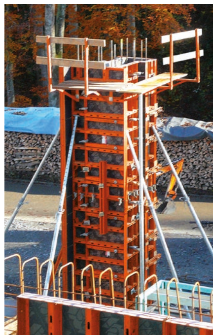
Garage, CH-Kerns; Baumeier Leitungsbau AG, CH-Luzern
