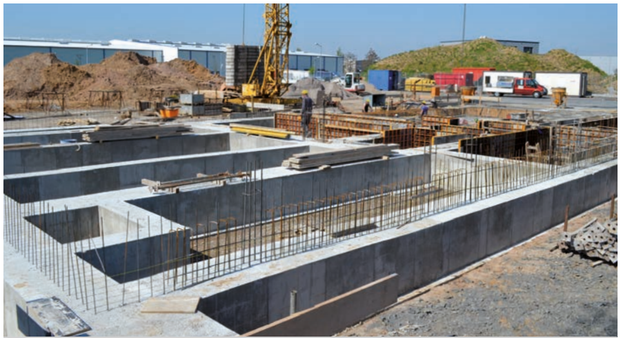
New construction of an office building with warehouse, D-Gelnhausen; Grauel Hoch- u. Tiefbau GmbH & Co. KG, D-Birstein
